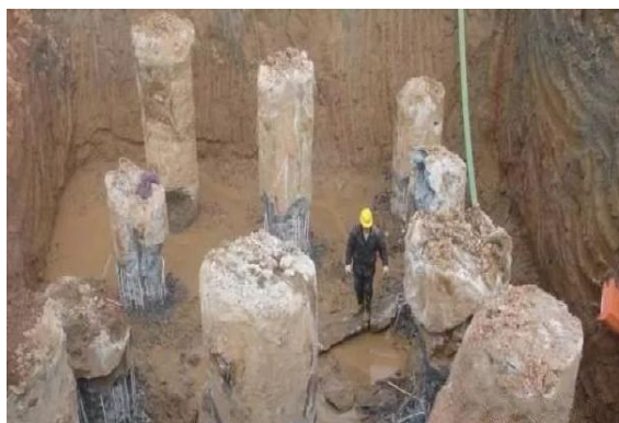
现场土质遇水易塌陷，搅拌后呈糊状。
