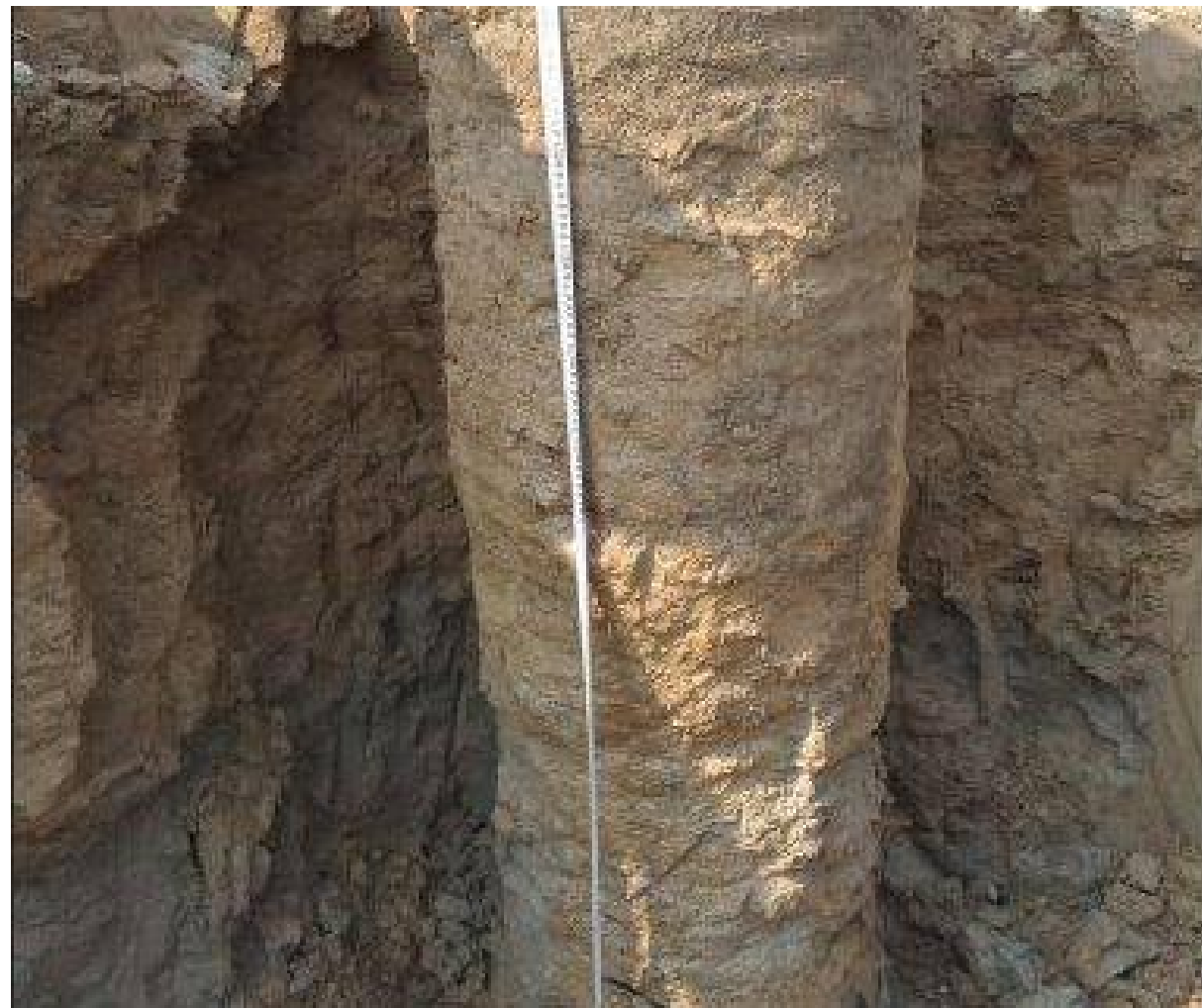
钻孔桩施工塌孔情况
