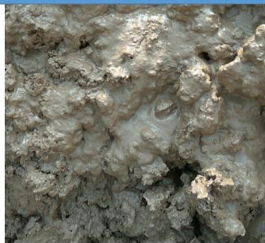
钻孔桩施工塌孔情况
