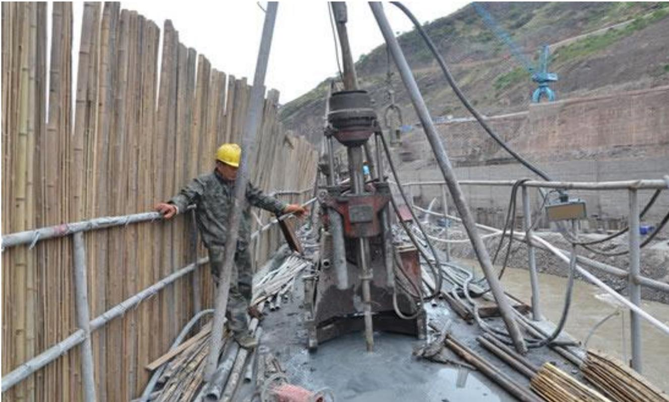
表 3.2.1 岩石地基固结灌浆单孔钻孔工序施工质量验收评定表（示例）
